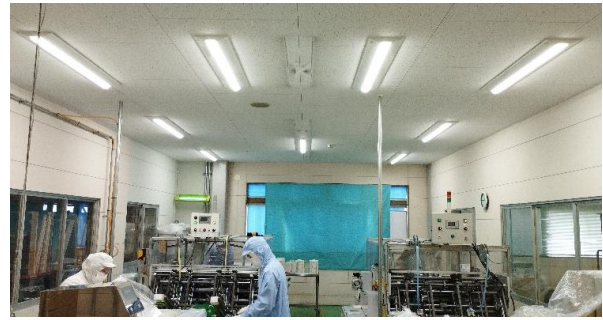
② 共同工場 製函エリアの照明をLED化
