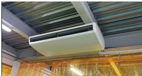
③ 共同工場 1階 エアコン 修理工事
